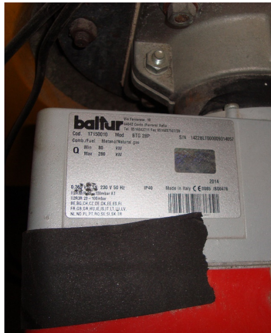
Figura 4.12 - Particolare bruciatore
