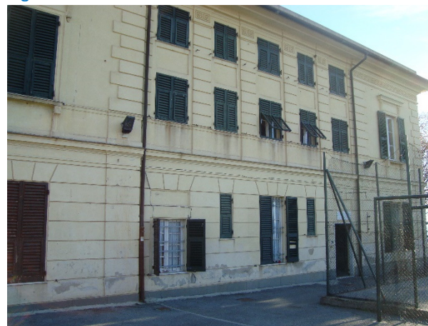
Figura 4.1 - Particolare facciata nord-ovest fabbricato
