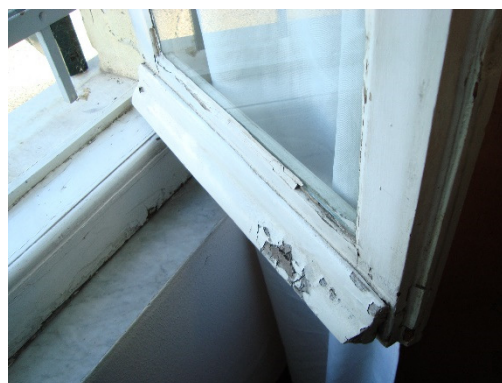
Figura 8.1 – Particolare dei serramenti esistenti
